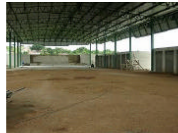
Área Interna da Feira Coberta
